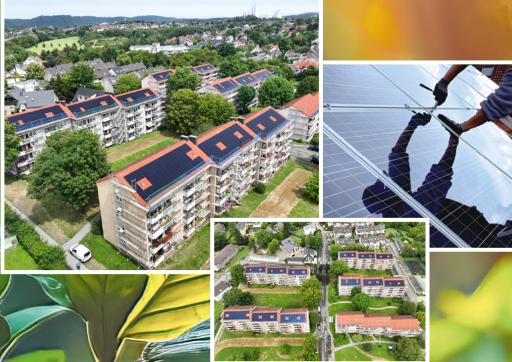
Fertiggestellte PV-Anlagen in Boelerheide
